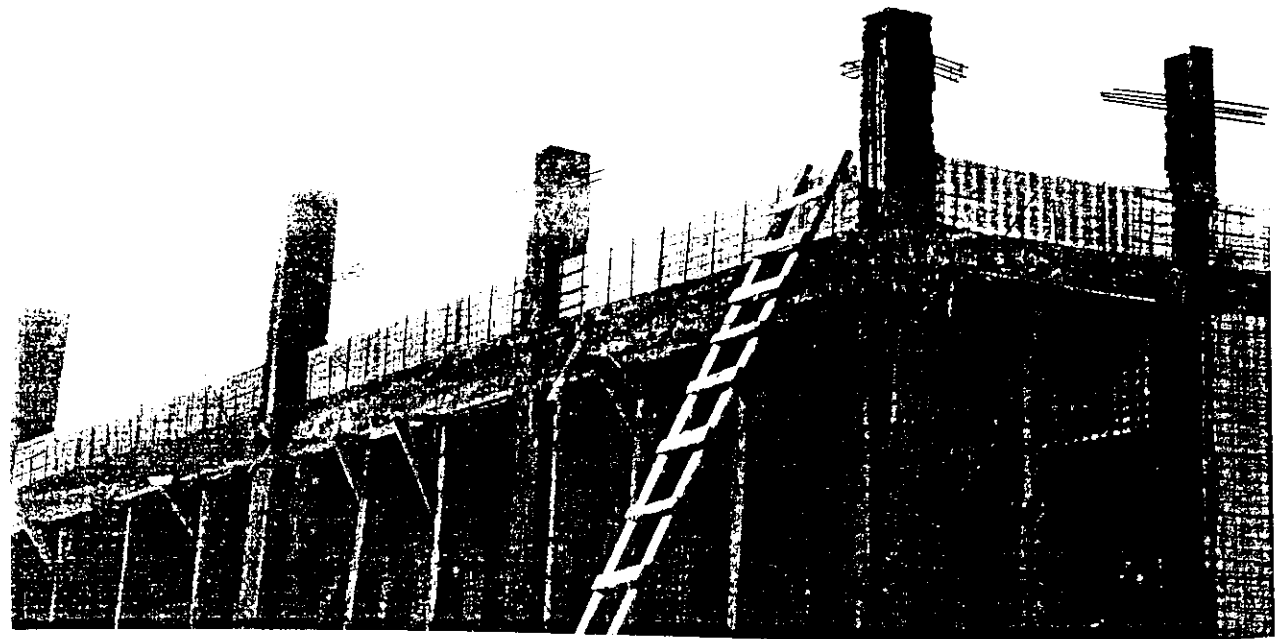
- Acrotère en panneaux et redisseuses coule pour terrasse 2ème plancher couler
