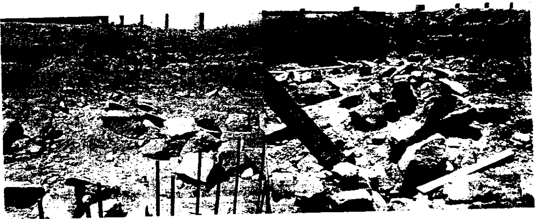
Excavation pour la piscine achevé
