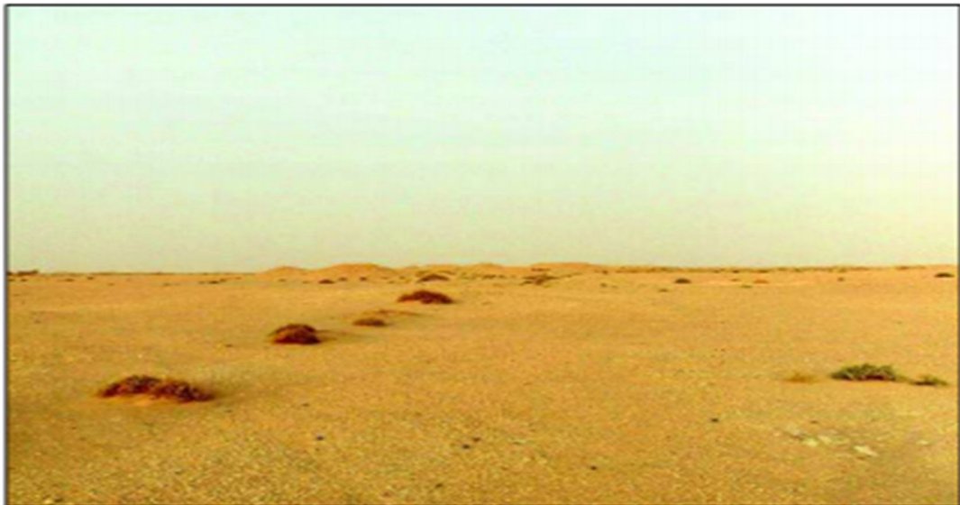
Fig. 3.4 : Puits de foggara effondrés et entièrement ensablés [43].
