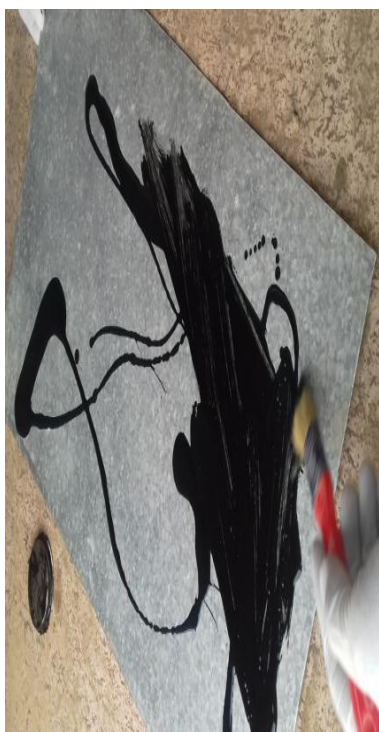
Figure IV.6: Revêtement de la surface d'absorbeur (interne)
