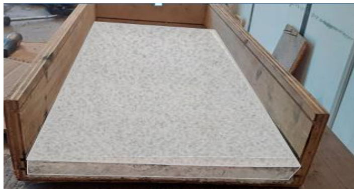
Figure IV.4: L'installation de la couche d'isolation.
