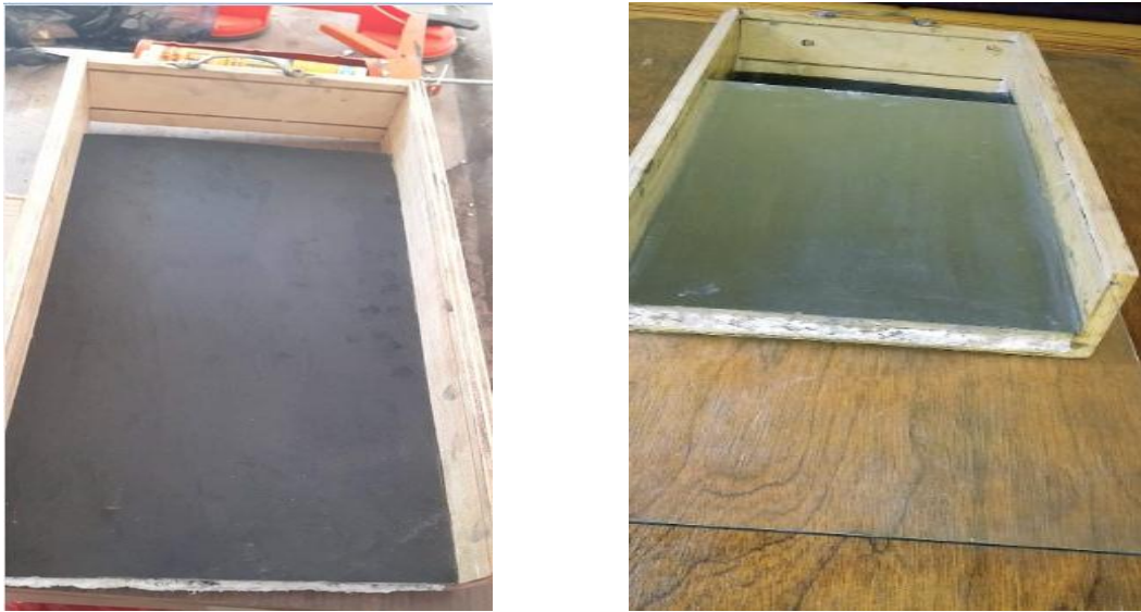
Figure IV.7: Installation de la plaque absorbante et le vitrage dans le cadre du capteur.
