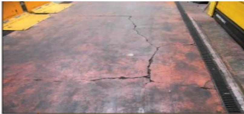
Figure I. 8: Retrait plastique à la surface d'une dalle en béton armé. [48]
