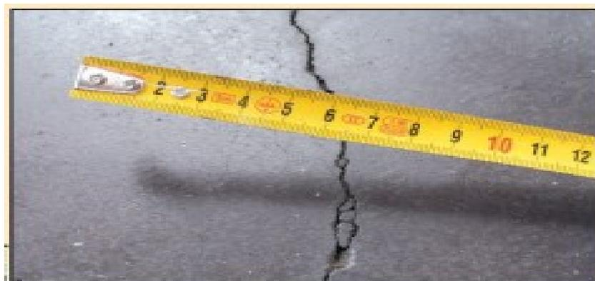
Figure I. 9 : Ouverture importante des fissures de retrait. [48]
