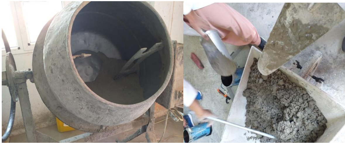
a- Malaxage du béton
