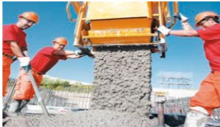
Figure I. 4: Mise en place du béton à la grue.
