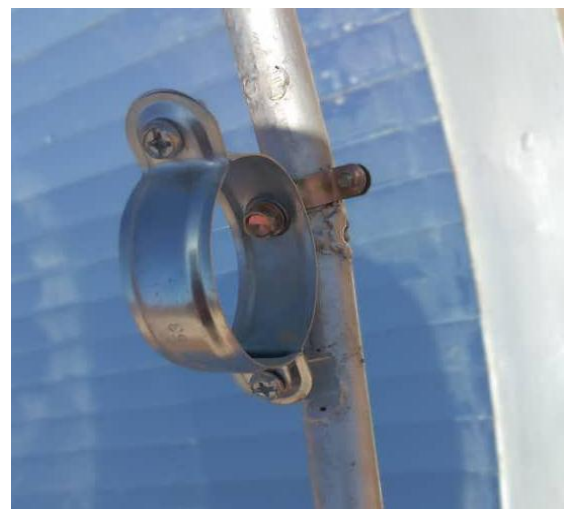
Figure III 7 : Image de l'anneau de support du tube récepteur
