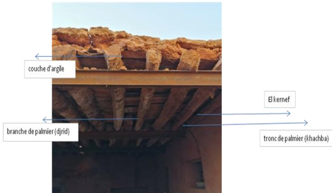
Fig.I. 13 : Schéma de disposition d'un plancher ancien à Tamentit.
