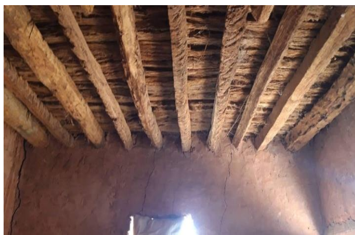
Fig.I.12: Ancien plafond à Tamentit.
