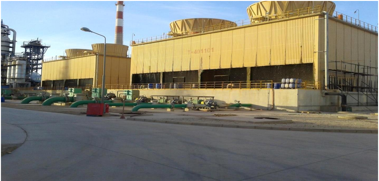
Figure I.9: Section de refroidissement de l'eau U401.
