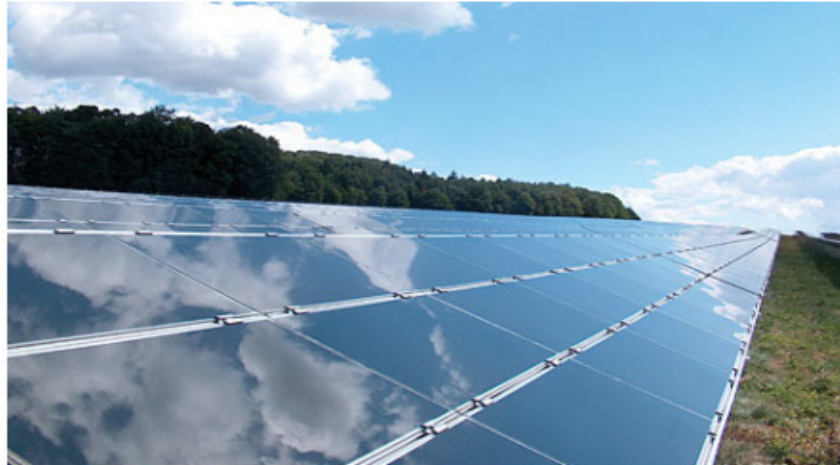
Figure 7: Modules verre-verre au Telluride de Cadmium, efficacité de 9 à 11% [8]
