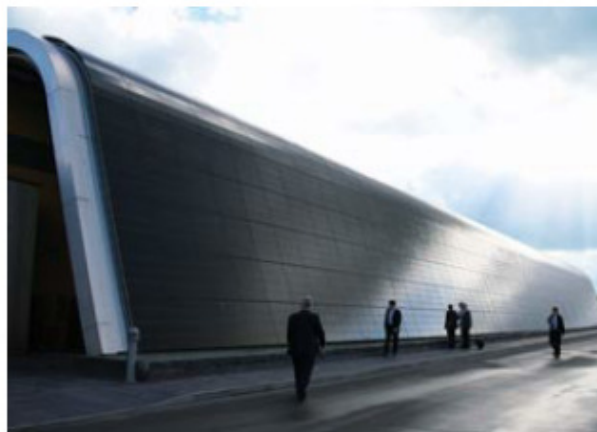
Figure 8: Façade en CIGS au Pays de Galles, efficacité de 8,5% [8]
