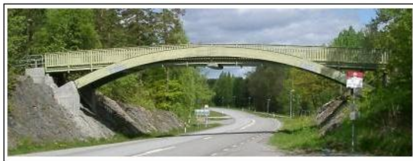
Figure II.12 : Passerelle en arc : Vaxholm, Stockholmslän(Suède) Source : http://www.structurae.de
