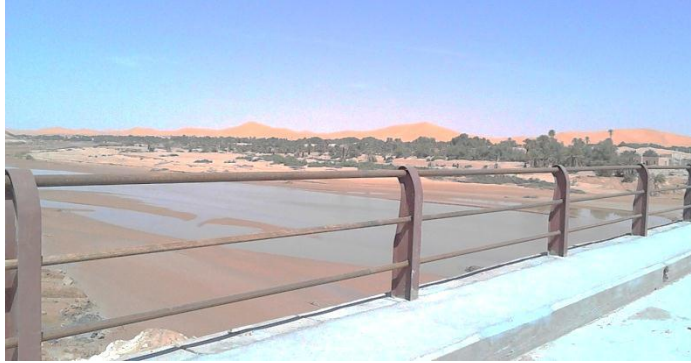
Figure II .14 : explique la Dispositifs retenue d'un pont (photo capturé lors de notre visite en site ksar El-ouata - wilaya de Bechar-2015)
