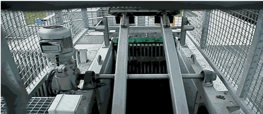
Figure II.1: Dégrilleur courbe (Mahdjar, 2016)
