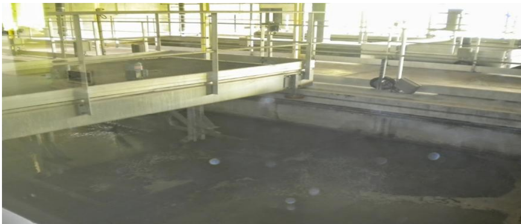
Figure II. 4: Déshuileur –dégraisseur (Benelmouaz, 2015)
