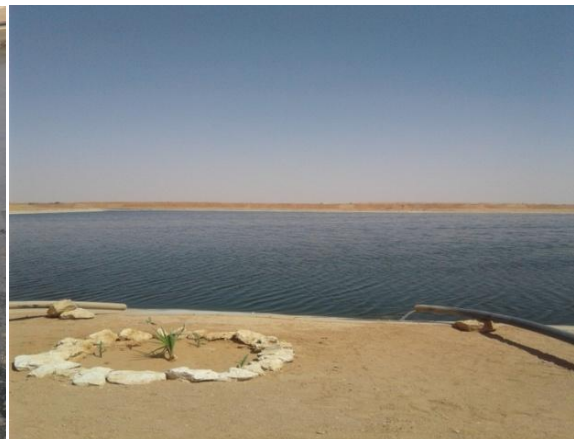
Photo III.7: Bassin de sortie des eaux épurées.
