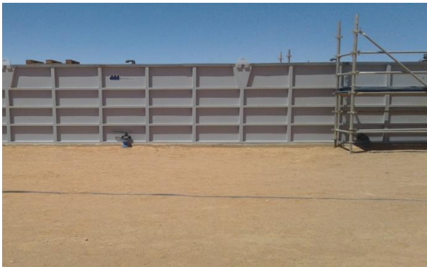
Photo III.3: Les réacteurs biologiques de la STEP.
