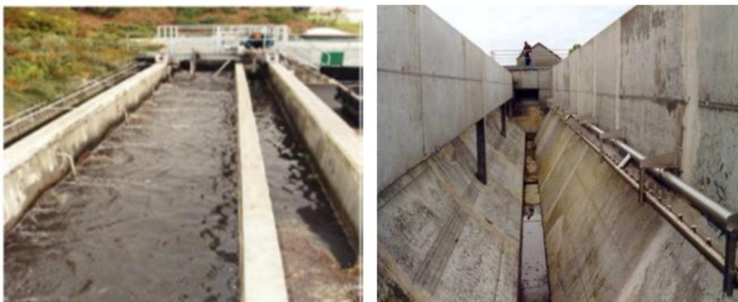
Figure II.3: Dessableur rectangulaire à insufflation (Mahdjar, 2016).
