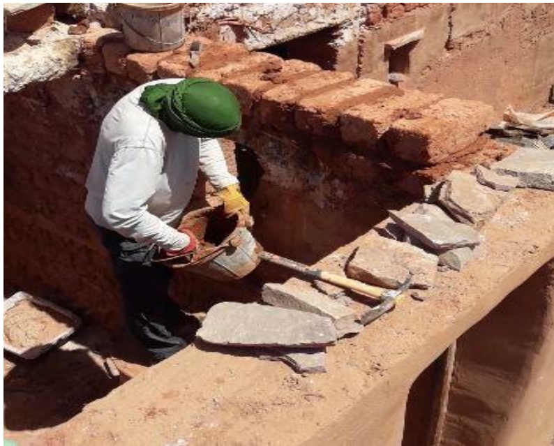
figure I. 76 :Réalisation de murs
