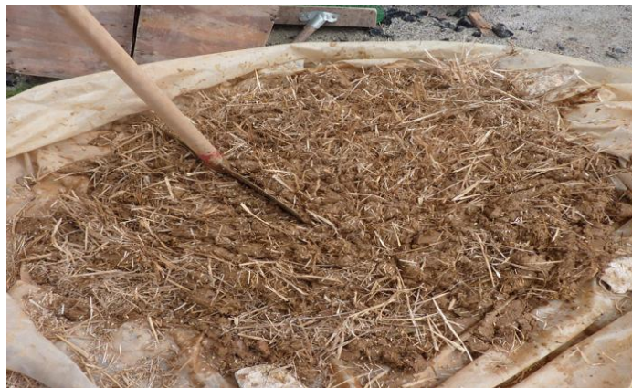
figure I. 74 :les fibres ( http : //www.cours-genie-civil.com/IMG/PDF/COURS-toitures-terrasses-APMBTP8_procedes-generauxde-construction PDF )
