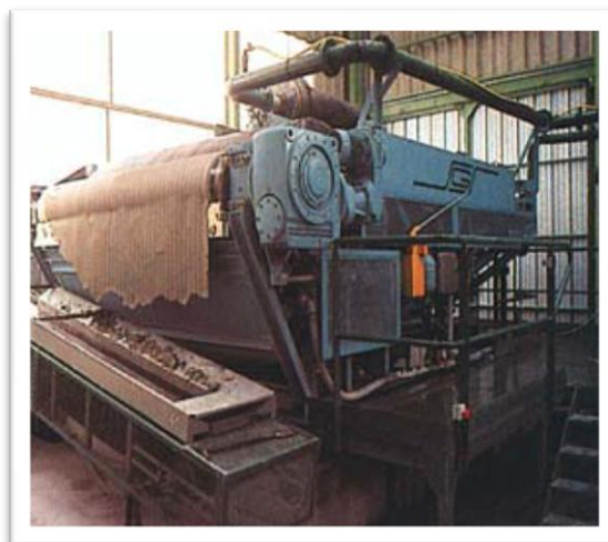
Figure 3 : Déshydratation par filtre presse.
