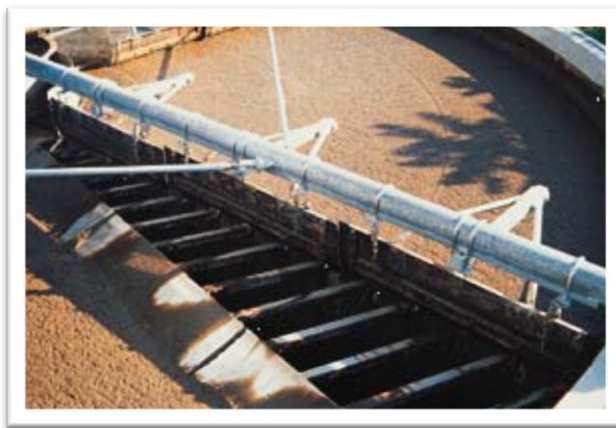
Figure 2 : Epaississement des boues par flottation.
