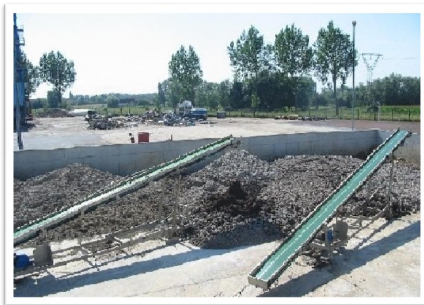
Figure 4 : Boues récupérées lors de la décantation.
