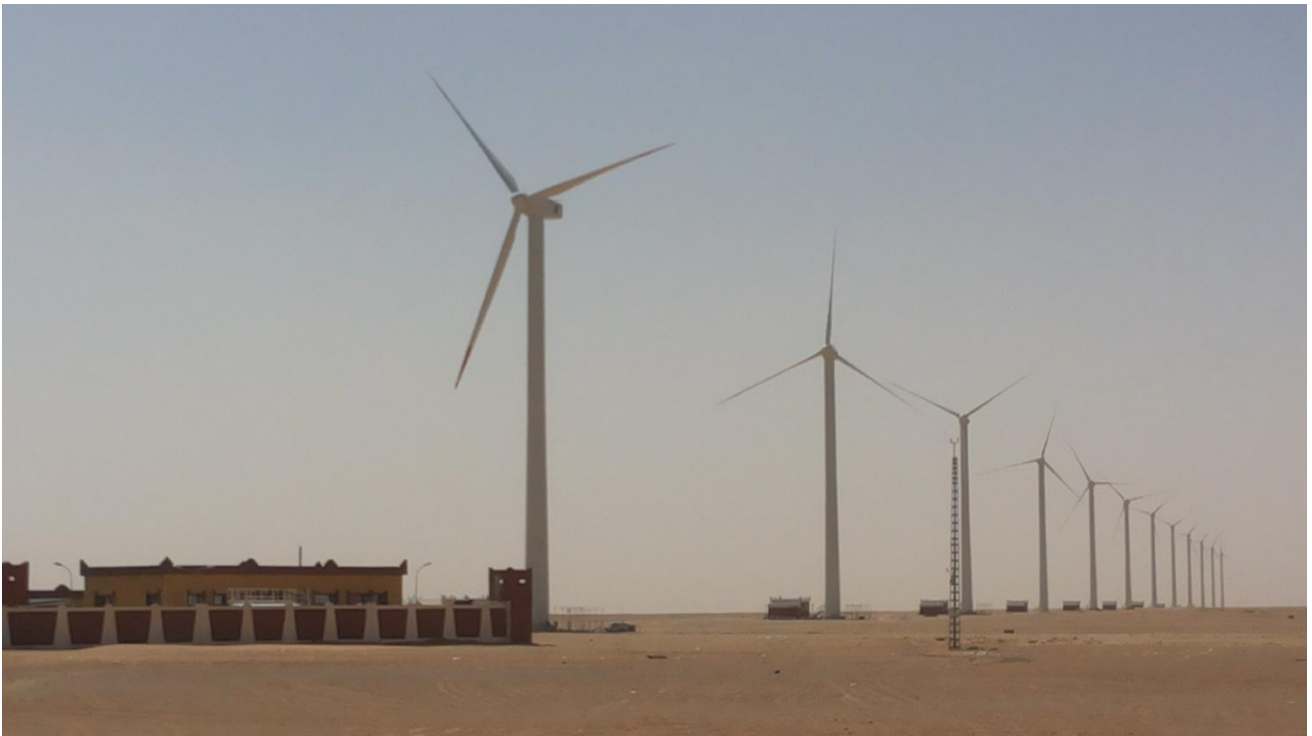
Fig III -9:-Vu Générale de la ferme Eolienne de KABERTENE
