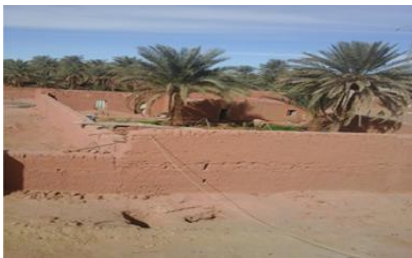
Figure(III.6) : Mur sans poteaux (auteur).
