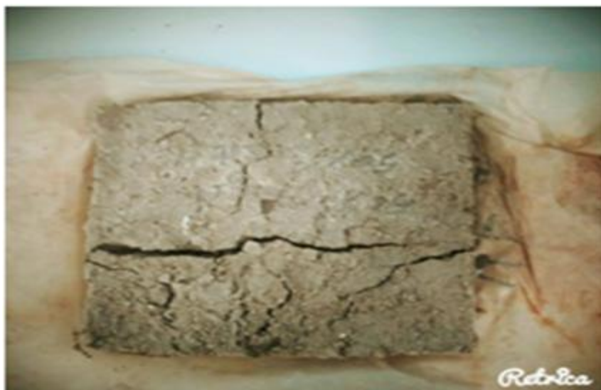
Figure(III.20) : l'échantillon fissuré (auteur).
