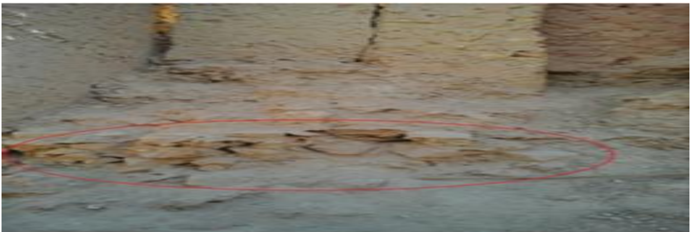
Figure(III.11) : Utilisation de grès comme un soubassement (auteur).
