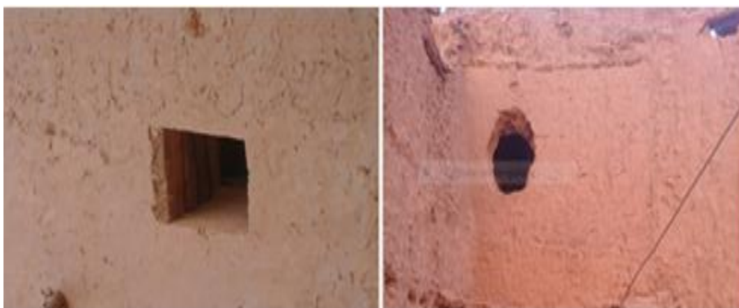
Figure(III.7) : Fenêtre de (40*40*84) cm.et trou dans le mur (auteur).
