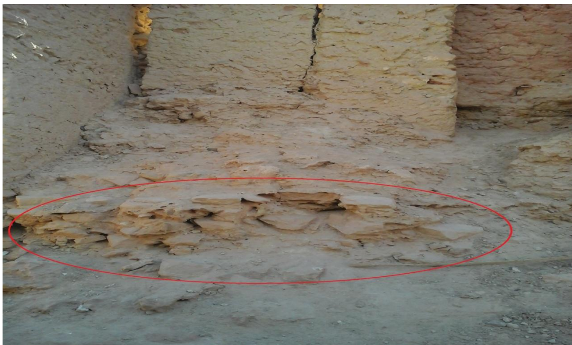
Figure(III.4) : Soubassement de 75cm (auteure).
