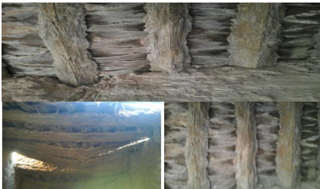
Figure(III.5) : Planchers en palmiers (auteur).
