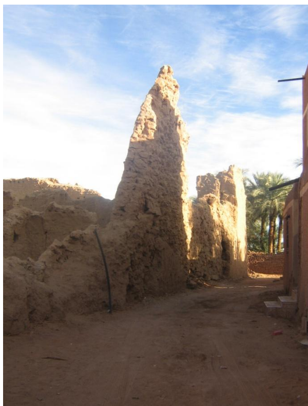
Figure(III.1) : Mur extérieur (auteur).
