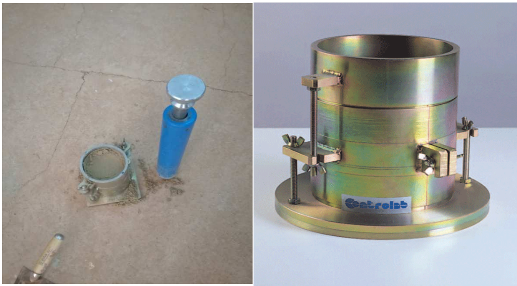
Photo II.8 : Réalisation de l'essai Proctor normal
