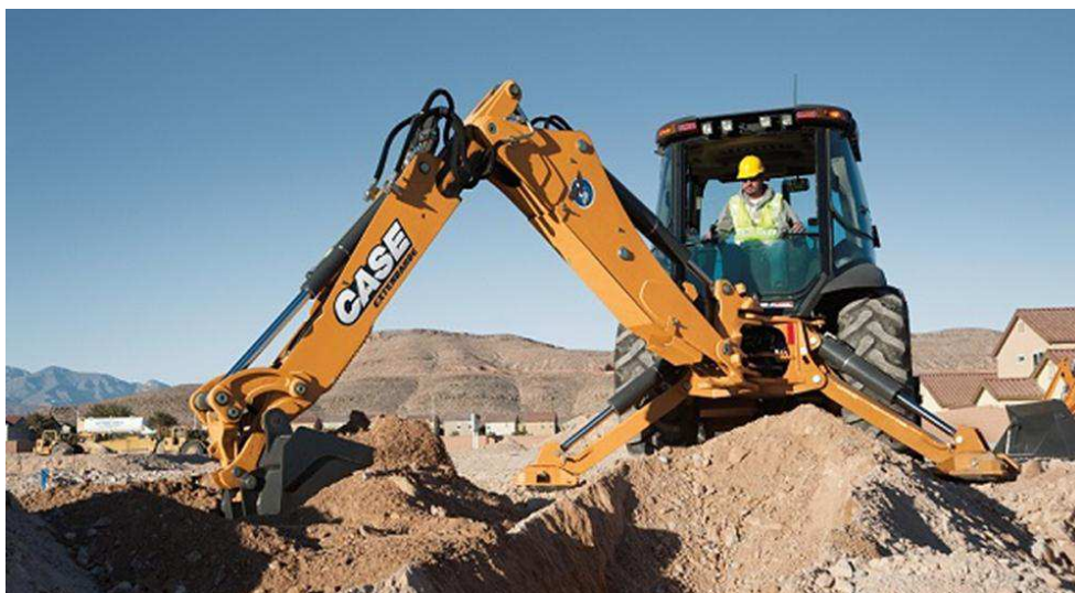
Photo I.2 : Fouilles à la rétro-caveuse
