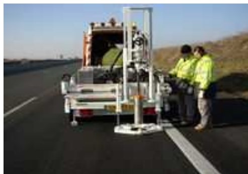
Photo I.5 : Carottage de chaussée
