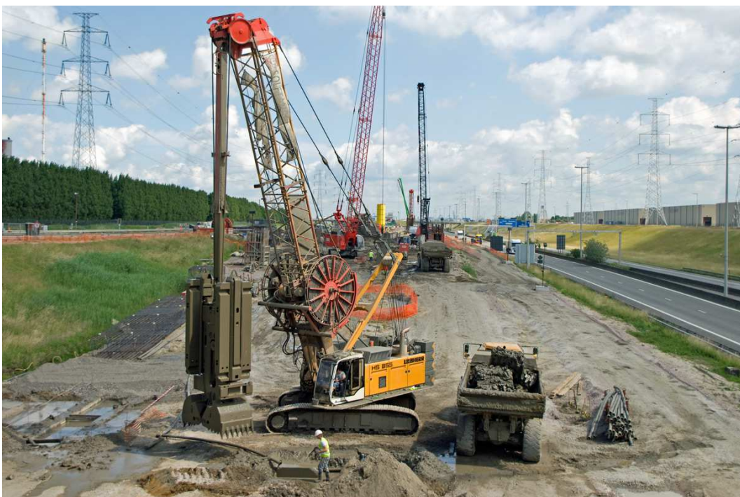
Photo I.3: Fouilles au grappin
