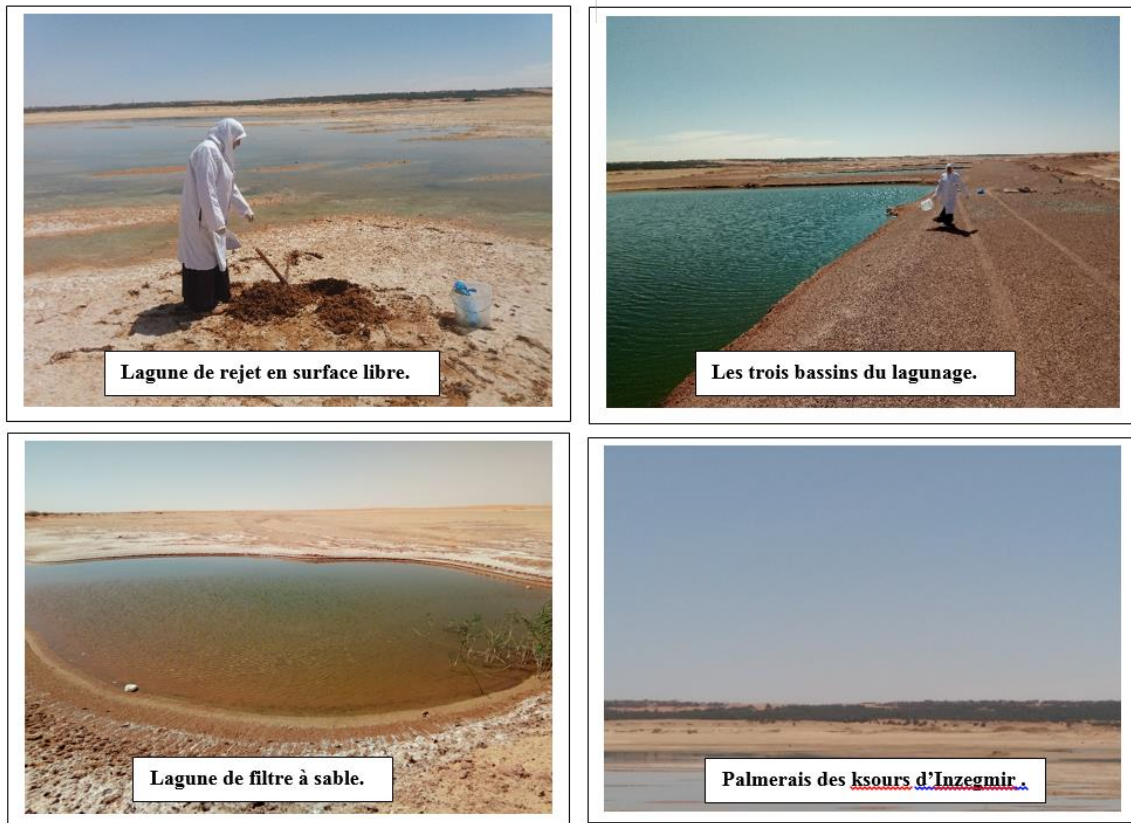
Figure 2: Photos de la station de lagunage de Tidmaine
