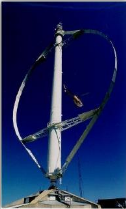
Éolienne de type Darrieus
