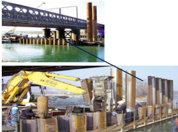
**Fig. 1.42.** Chantier d'une reconstruction d'un pont en utilisant des palplanches métalliques.
