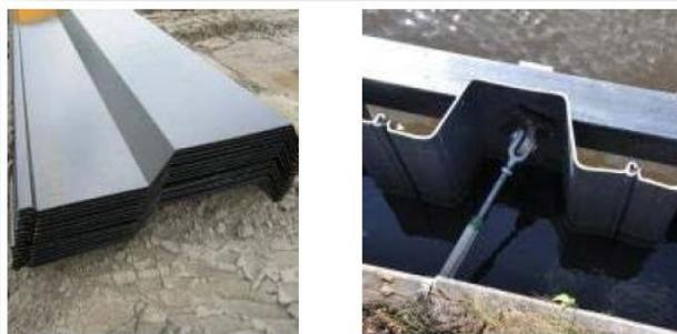
**Fig. 1.4.** Palplanches laminées à froid.
