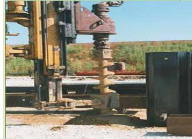
**Fig. 1.48.**Perforage avant fonçage
