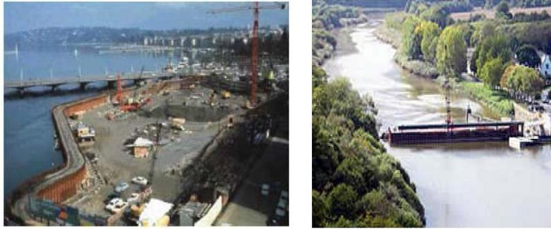
**Fig. 1.34.** L'utilisation des palplanches comme batardeaux en rivière.
