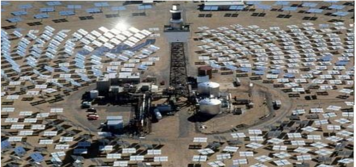
Figure (III-11): Système de centrale à tour [29].
