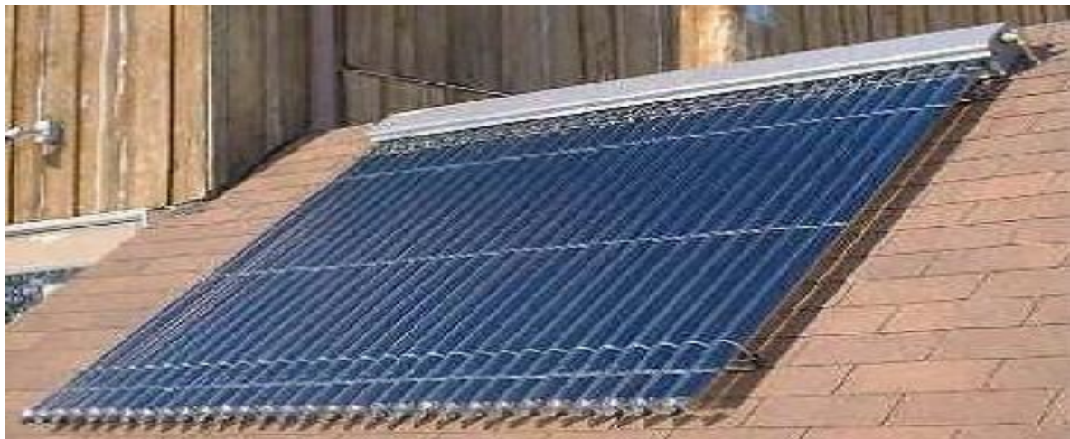
Figure (III-8) : Capteur solaire à tubes sous vide [5].
