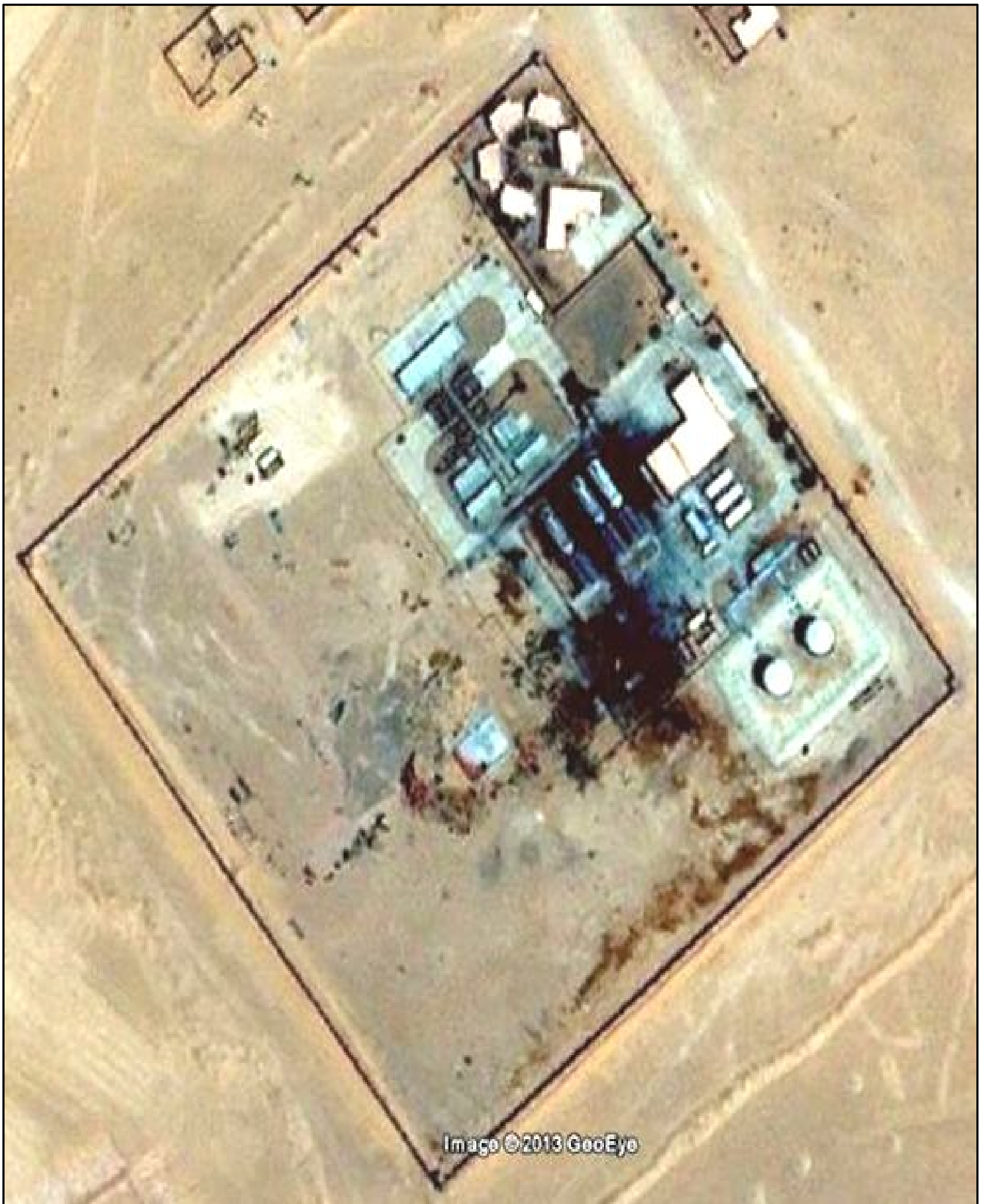
Figure 11/: Image Google Earth de la centrale Diésel Talmine
