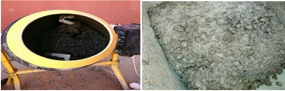
Figure III. 19 : Préparation de béton ordinaire et béton malaxé
