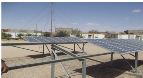
(a) Générateur photovoltaïque
