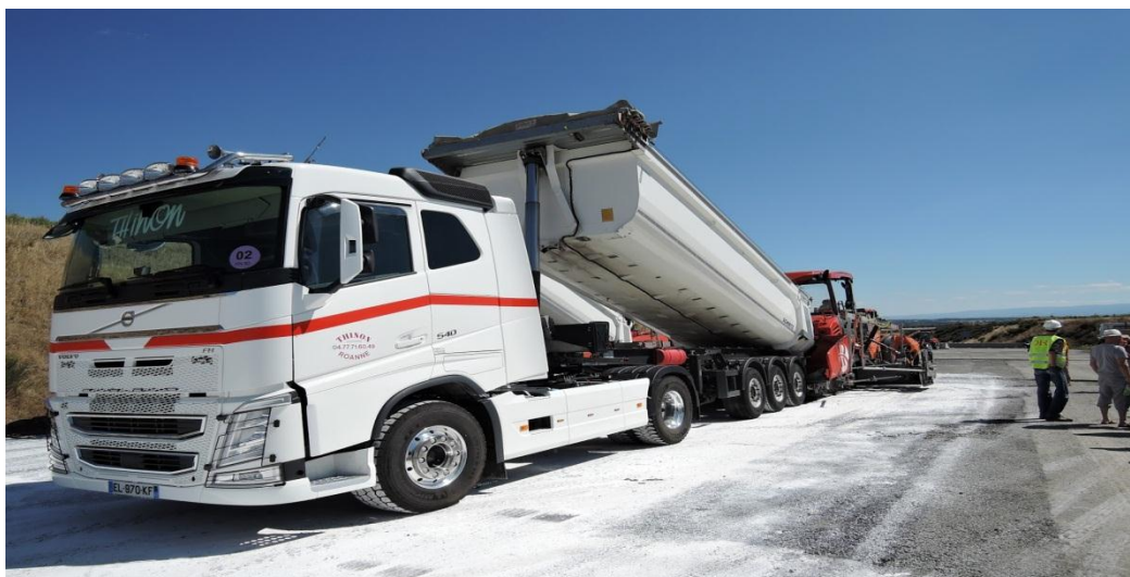
Figure (9) : Camion d'enrobé bitumineux [19]
