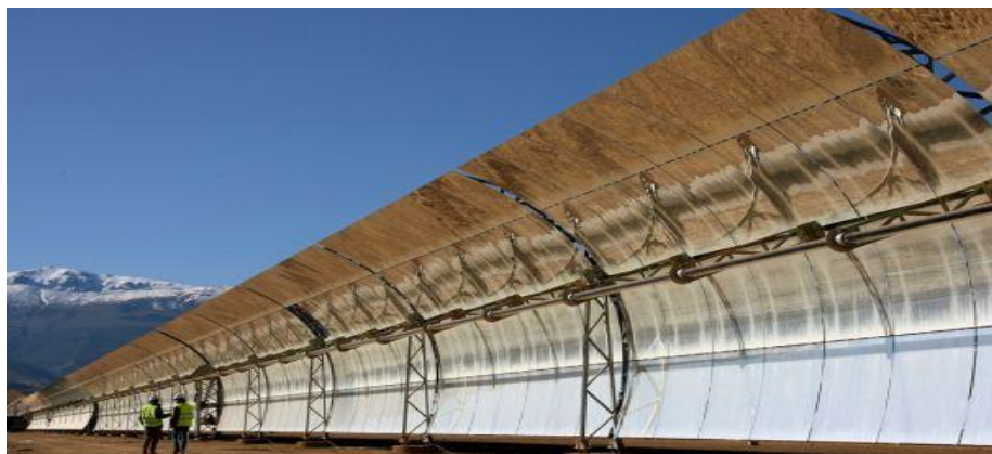
Figure II.4 : Système à réflecteur cylindro-parabolique[8]
