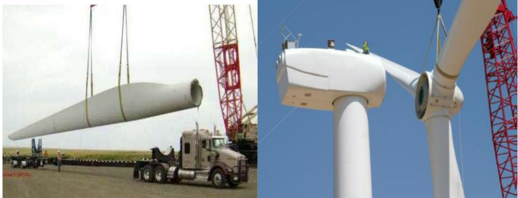
Figure I. 13. Montage des pales d'éolienne [42]
