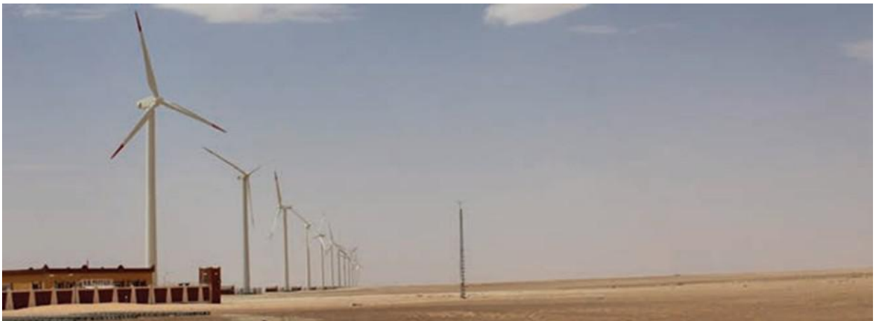
Figure III. 1. La ferme éolienne de Kaberten [7]
