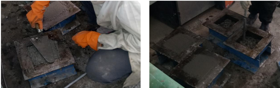
Figures IV.9 : Mise en place du béton dans le moule
