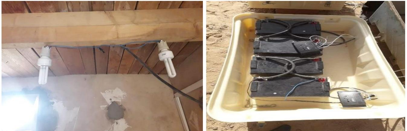
Figure IV.7: Photo de la lampe à courant continu et des batteries
