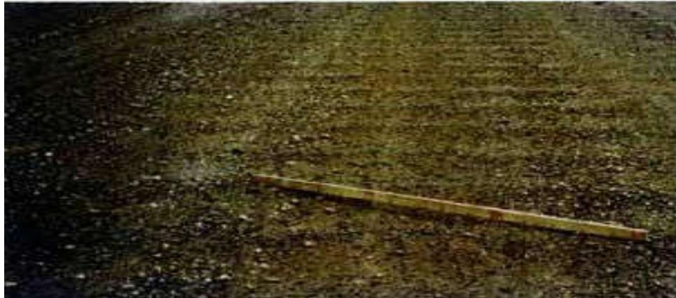
**Photo.III.3– Tôle ondulée [8].**
