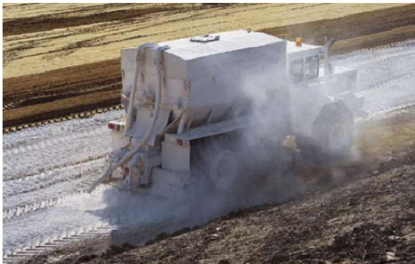
**Photo I.2 Incorporation de la chaux ou du ciment à l'aide d'un épandeur**
