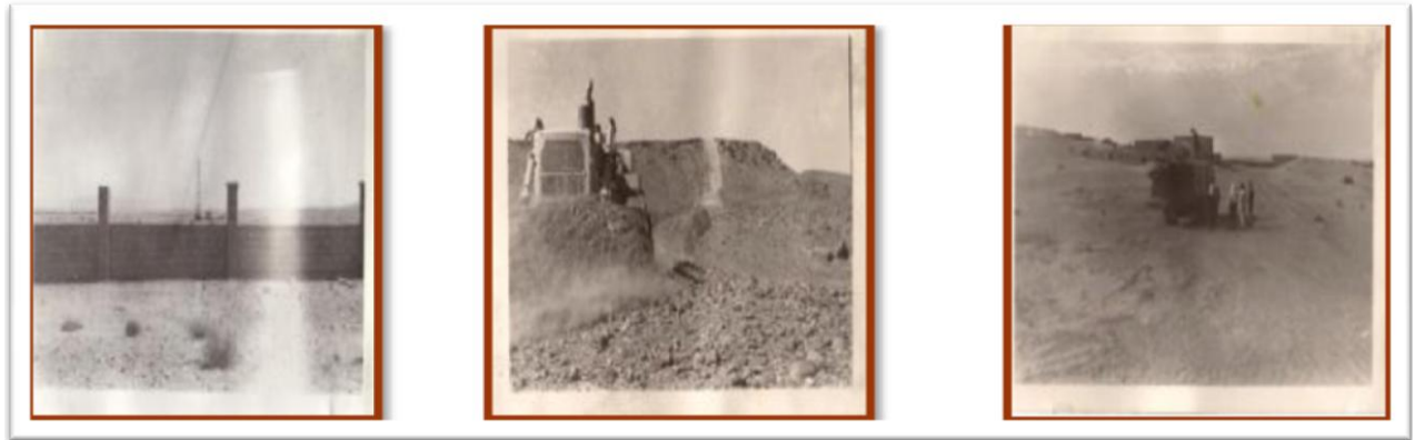
Photo II. 3: Travaux de construction du Barrage Djorf Torba de 1951-1954[19]
