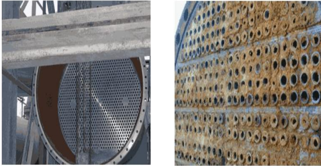
Figure 3.1: Echangeur propre Figure 3.2 : Echangeur encrassé
