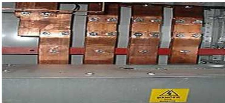
**Fig.II.1 : Barres de distribution électriques en cuivre fournissant l'énergie à un grand bâtiment.**
