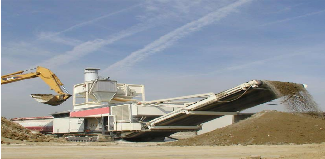
Figure III.6 : Traitement des sols par la chaux en malaxage dans l'installation [23].
