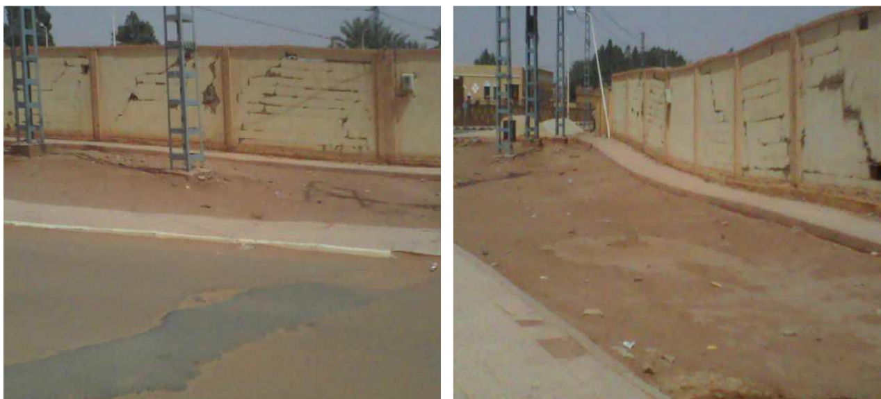
Figure I.1. Désordres provoqués par le gonflement à In-Amenas
