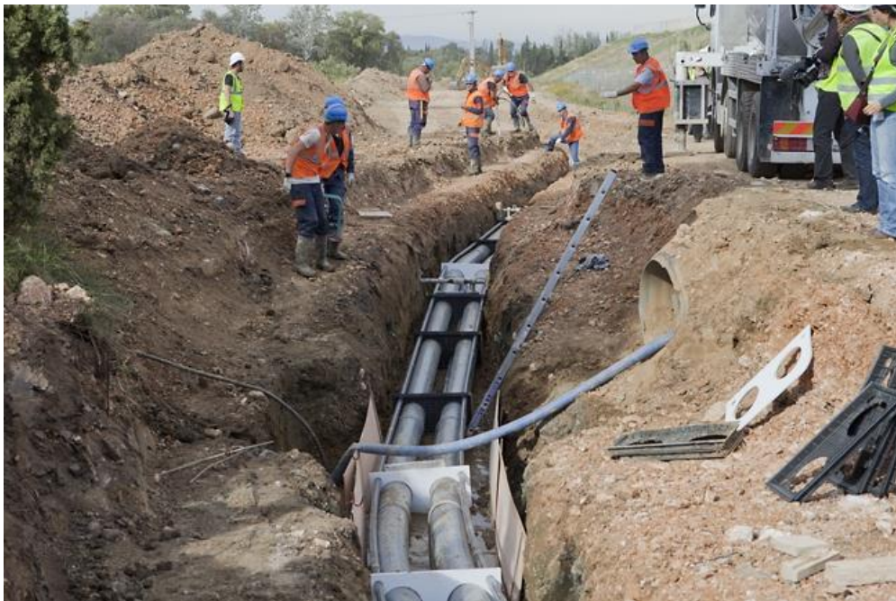
Figure I.14 : Des travaux sur les lignes souterraines. [13]
