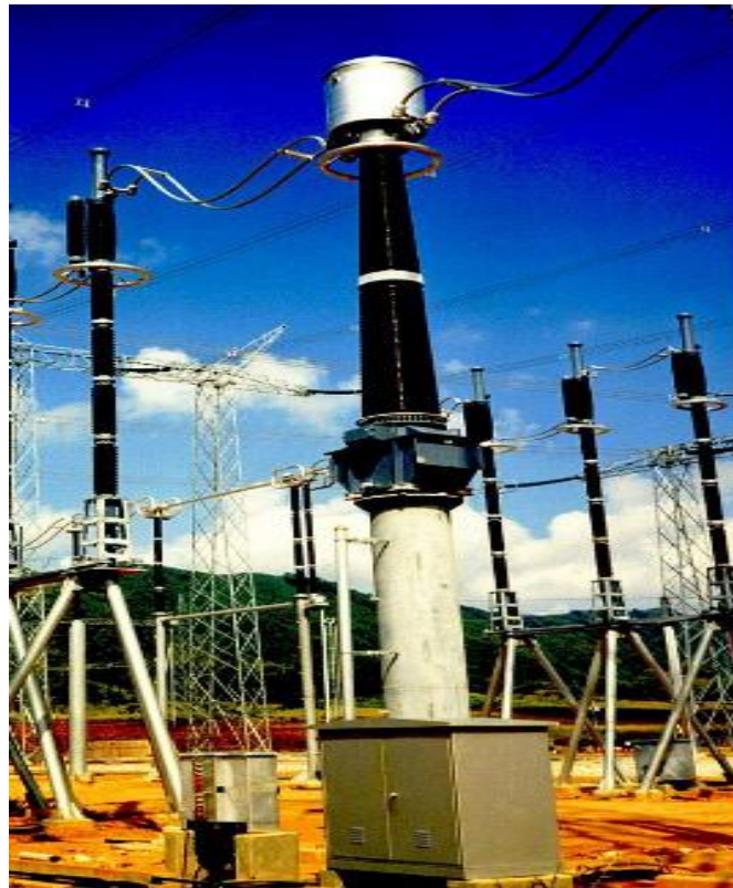
Figure I-13 : Disjoncteur 800kv. [11]
