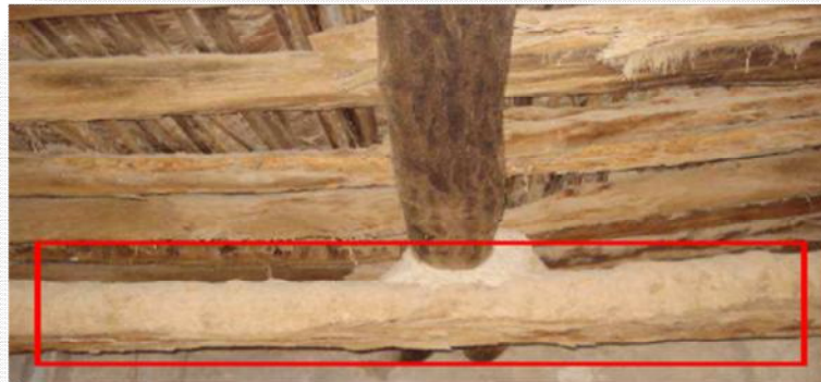
Figure 24 : d'un montant en bois, Témacine
