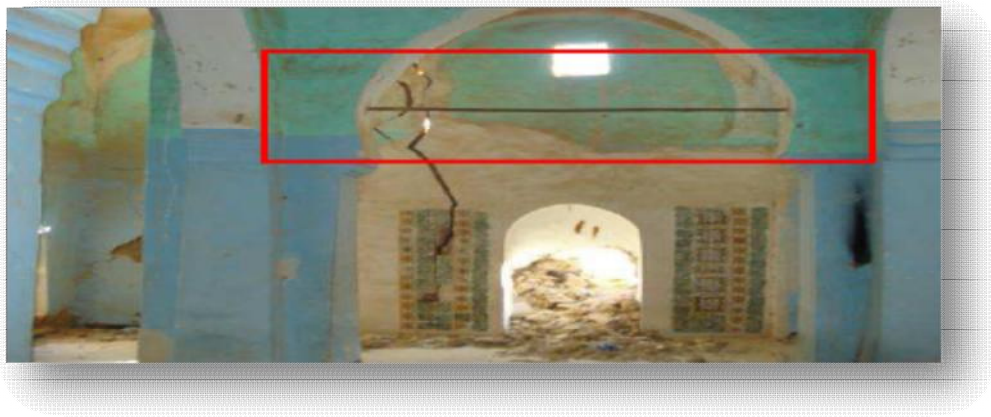
Photo 25 : Consolidation de la voûte par un tirant métallique, Témacine
