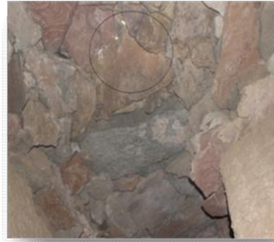
Photo 30 : Dalles de pierre constituant le plafond (plancher supérieur) de la galerie
