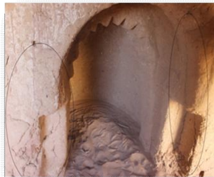
Photo 30 : Dalles de pierre constituant le plafond (plancher supérieur) de la galerie
