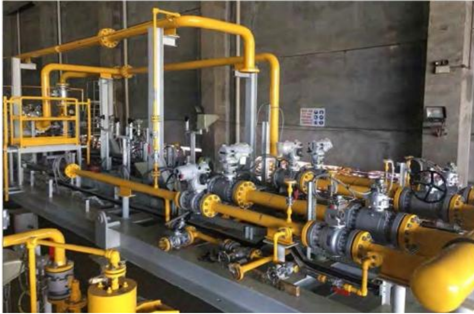
Figure. II.1 système de comptage de gaz d'exportation [GTIM]
