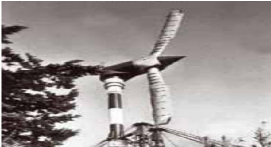
Fig.I.7 Eolienne de 100 kW de Grand Vent [9]
