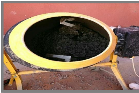
Figure 36: préparation de béton ordinaire
