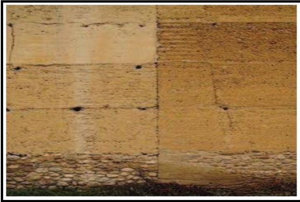
Figure.5 : Mur en pisé [3].
