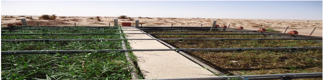
Photo 18 : Les deux filtres plantés de roseaux de la station.
