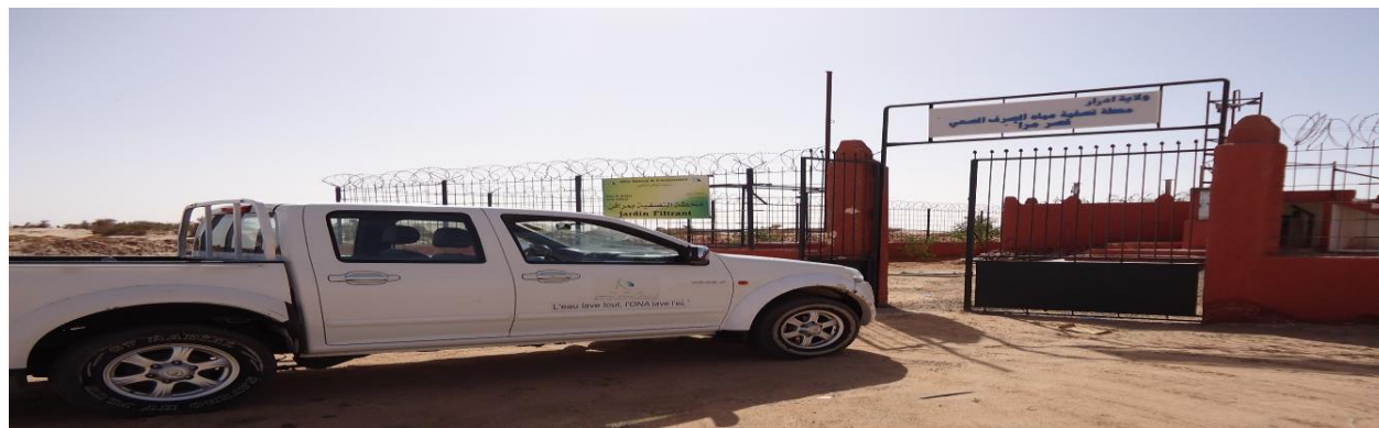
Photo 10 : La station d'épuration du Ksar de M'raguen
