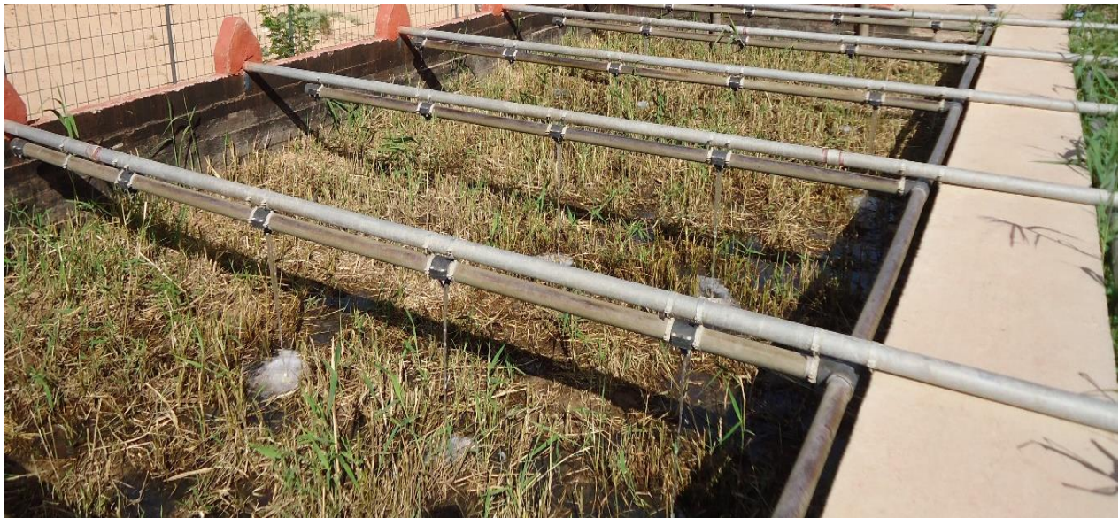
Photo 19 : L'alimentation du filtre par bâchée.
