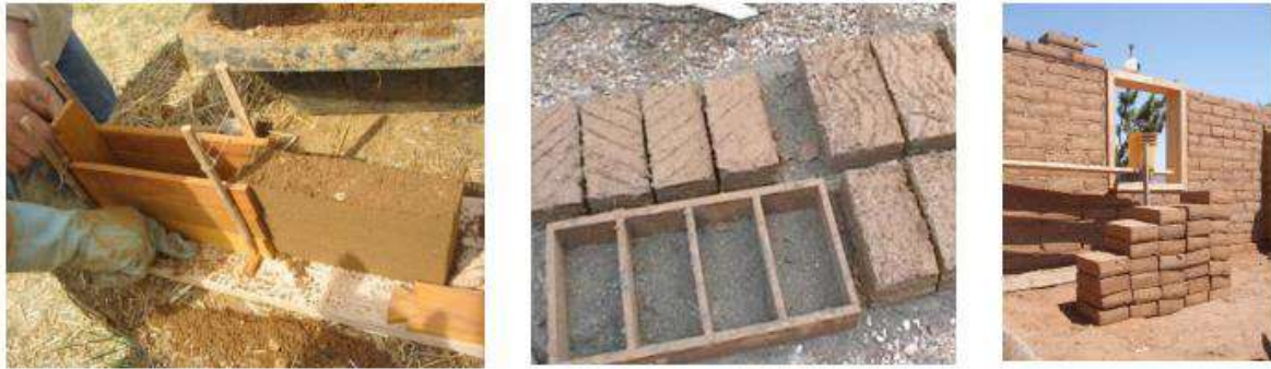
Figure I. 6 : Technique traditionnelle de l'Adobe(Hibouche, 2013).
