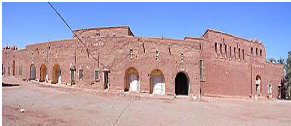
Figure I. 1 : Ancien Hôpital d'Adrar – Touat (H Abdne, 2007)
