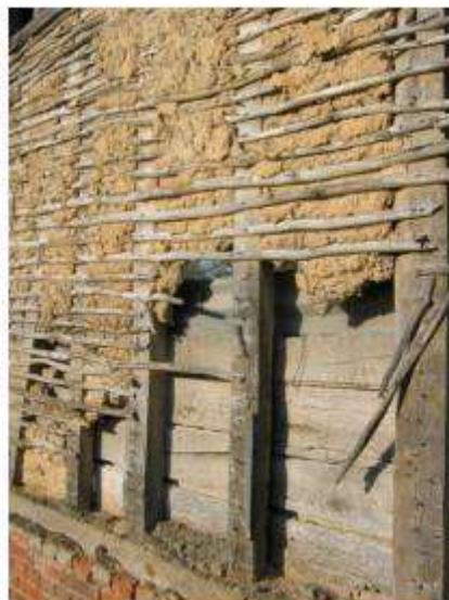
Figure I. 5 : Technique traditionnelle (mur en Torchis)(Ngo, 2017)
