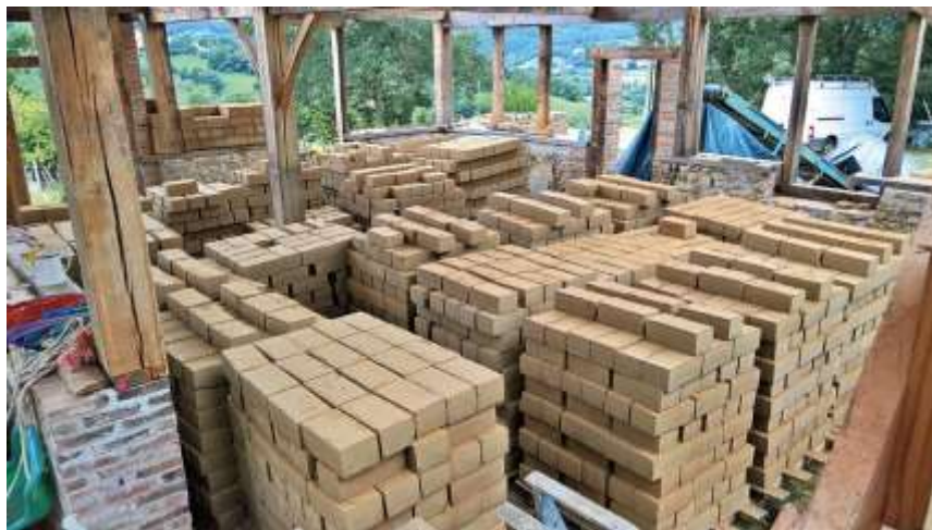
Figure.II. 10: Stockage des briques de terre (Internet, 2026)
