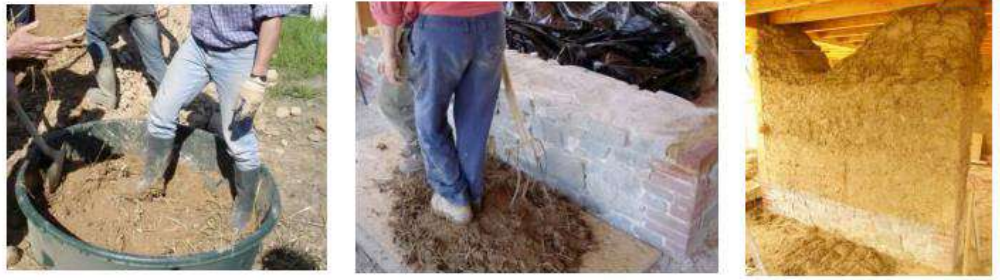
Figure I. 4 : Technique traditionnelle de la bauge(Ngo, 2017)
