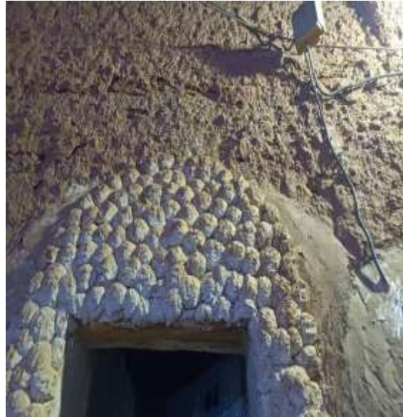
Figure I. 16 : Revêtement extérieur du mur
