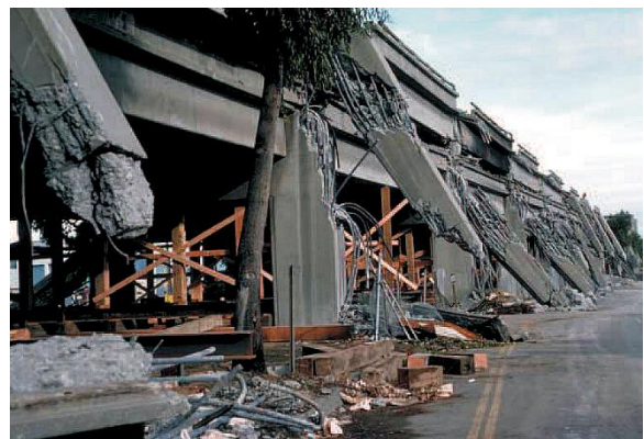
(b) Viaduc Cypress Street à Oakland, Loma Prieta (1989)
