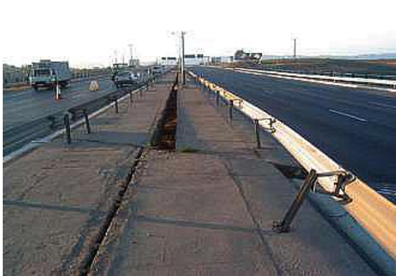
(a) Déplacement horizontal du tablier d'un pont sur Oued El Harrach sens Ben Aknoun - Dar El Beida
