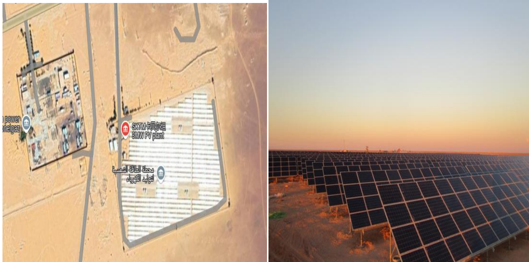
Figure II.03. Situation géographique de centrale Kabertene.
