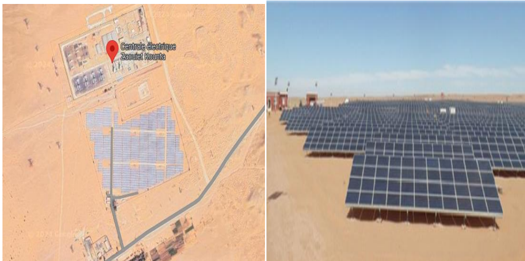
Figure II.05. Situation géographique de centrale Zaouiet Kounta.
